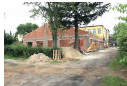
Rozbudowa szkoły w Paprotni
