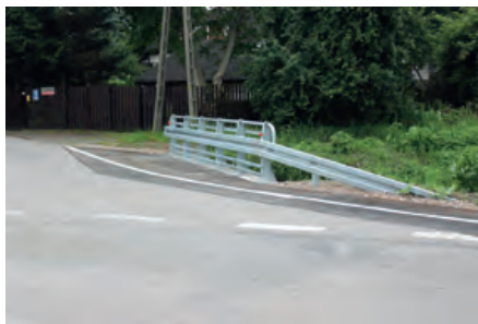
Przepust na rzece Teresince na ul. Cmentarnej w Paprotni
