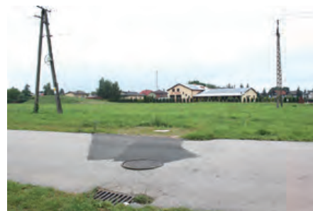
Wybudowanie sieci kanalizacji deszczowej przy ul. Łąkowej na Osiedlu Granice
