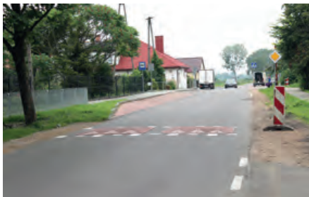
Przebudowa drogi gminnej Kawęczyn – Mikołajew
