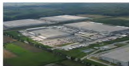
Centrum logistyczne / Logistics center
