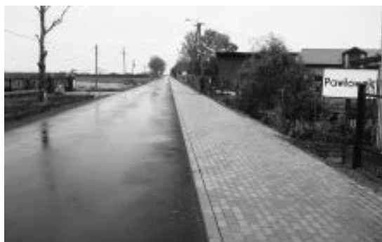
Pawłówek - nowy asfalt i chodnik
