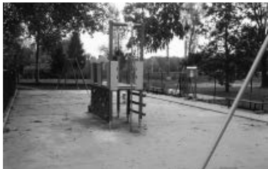
Budowa placu zabaw w Masznie
