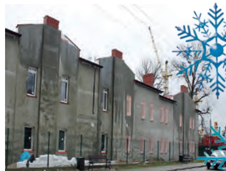
Budowa obiektu GOSiR Teresin
