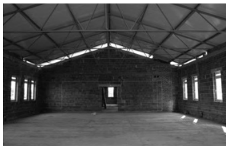
Budowa zaplecza GOSiR
