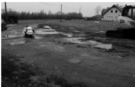
Budowa kanalizacji w ul. Książęcej w Teresinie
