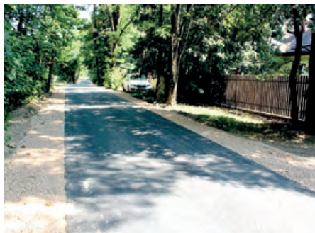
Droga w Pawłowicach już po remoncie
