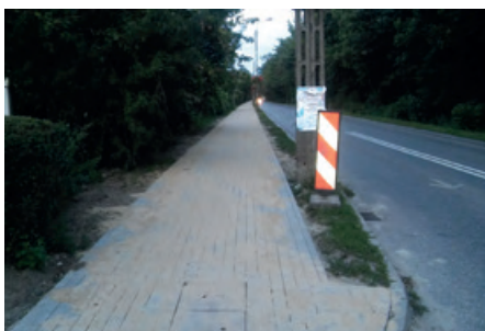
Przebudowany chodnik przy Al. XX-lecia
