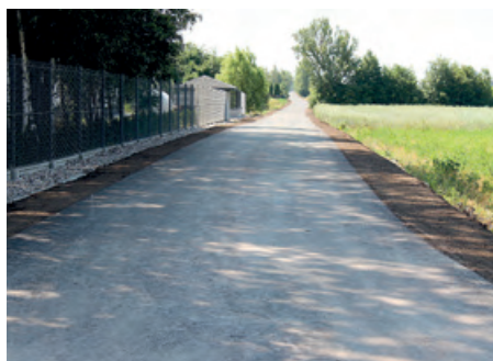
Wyremontowana ul. Jarzębinowa w Serokach
