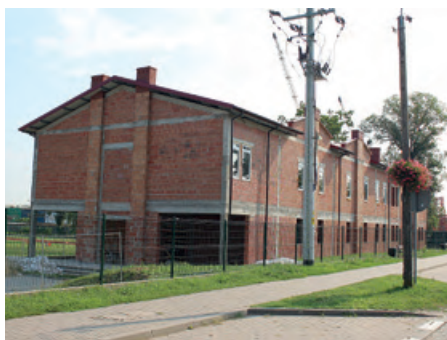
Budowa zaplecza GOSiR
