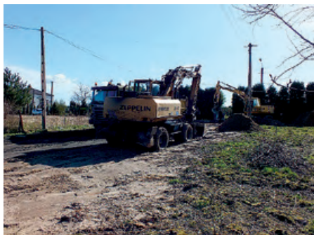
Budowa kanalizacji w Granicach
