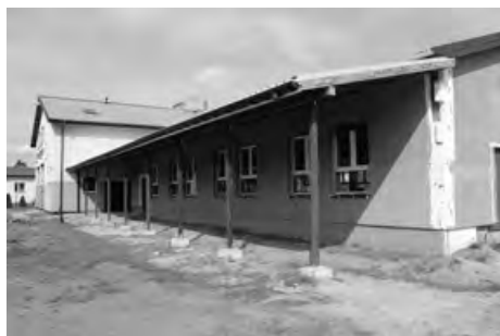
Adaptacja wielofunkcyjnej świetlicy przy OSP Teresin
