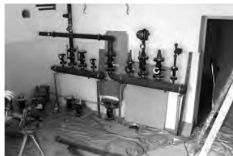
Szkoła Podstawowa w Paprotni – przebudowa kotłowni
