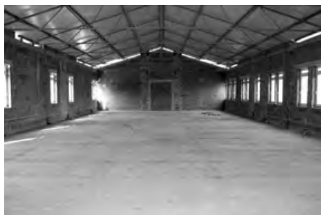
Prace wykończeniowe w budynku zaplecza GOSiR
