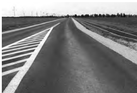
Droga Szymanów – Aleksandrów wraz z nową ścieżką rowerową
