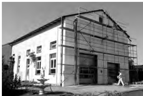
Termomodernizacja budynku OSP Niepokalanów
