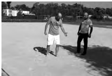
Szymanów - budowa boiska do piłki plażowej
