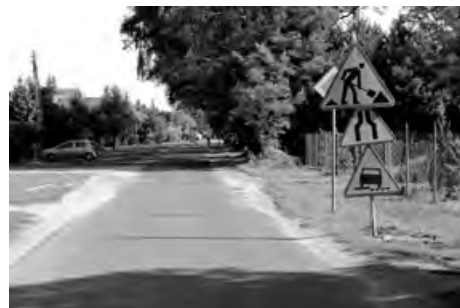
Modernizacja ul. Kaskiej w Teresinie
