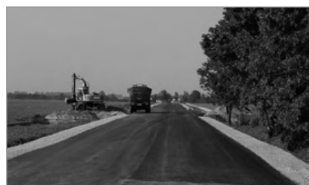
Gruntna przebudowa drogi powiatowej Szymanów – Aleksandrów
