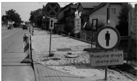
Przebudowa chodnika na ul. o. Kolbego w Paprotni
