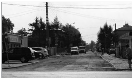
Prace na ul. Rynkowej w Teresinie
