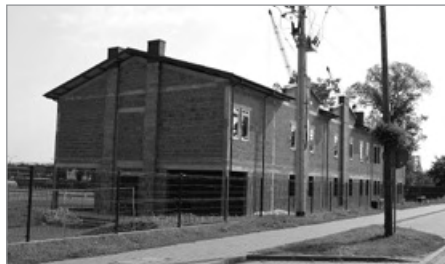
Zaplecze GOSiR – roboty wykończeniowe
