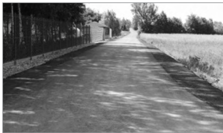
Wyremontowana ul. Jarzębinowa w Serokach
