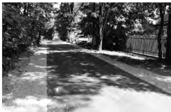
Droga w Pawłowicach już po remoncie
