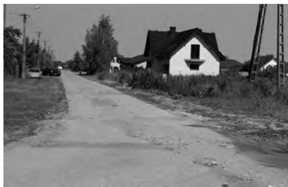
W ulicy Spacerowej w Teresinie-Gaju wybudowano kanalizację deszczową
