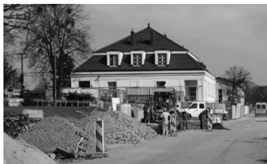
Remont dworca PKP i przebudowa kanalizacji deszczowej
