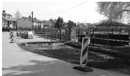
Budowa miejsc parkingowych na Osiedlu Granice
