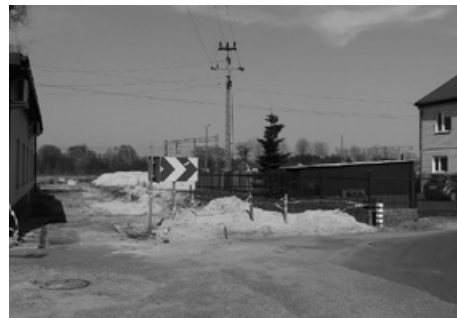
Prace nad połączeniem ul. Guzowskiej z ul. Torową w Teresinie
