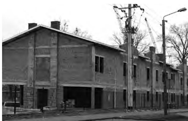
Budowa zaplecza sportowego GOSiR
