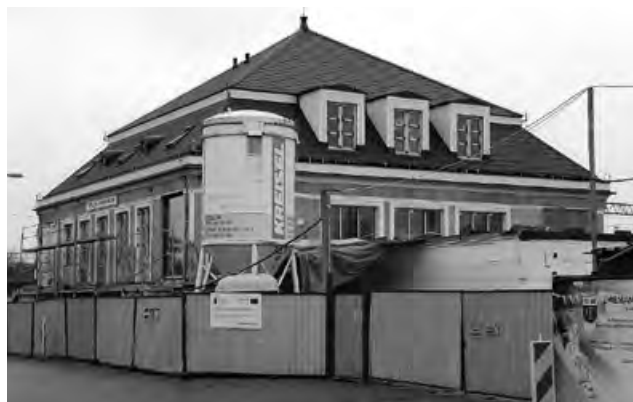
Trwa przebudowa dworca PKP
