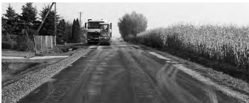
Maurycew - modernizacja drogi
