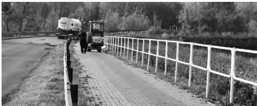
Szymanów - budowa oświetlenia ścieżki rowerowej
