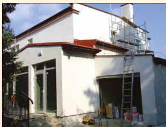
Rozbudowa Ośrodka Zdrowia w Szymanowie
