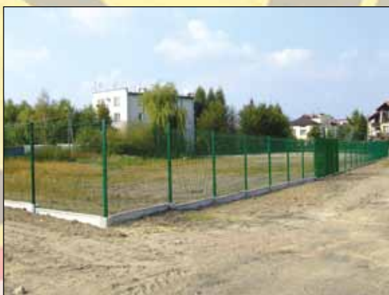
Ogrodzenie placu zabaw i boiska na osiedlu Granice
