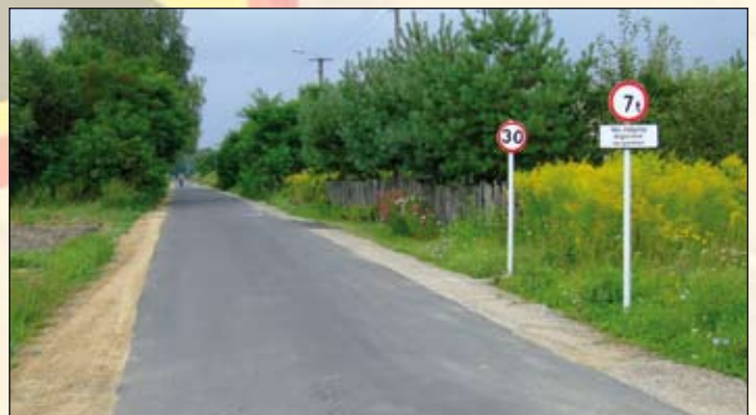
Droga w Witoldowie
