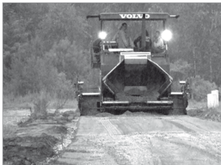
Modernizacja drogi w Izbiskach
