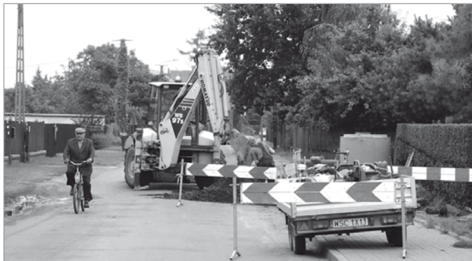
Budowa kanalizacji deszczowej - ul.Kaska w Teresinie
