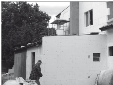
Modernizacja Ośrodka Zdrowia w Szymanowie
