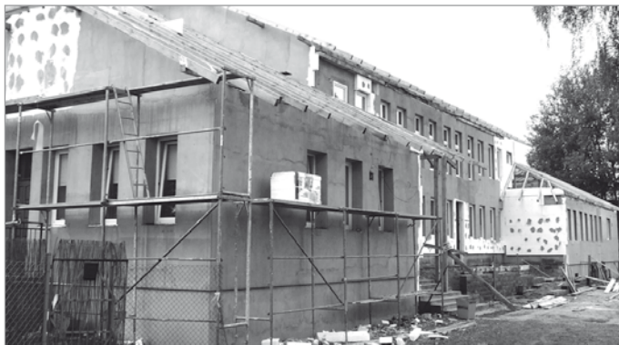
Docieplanie budynku GZGK i Przedszkola w Teresinie.
