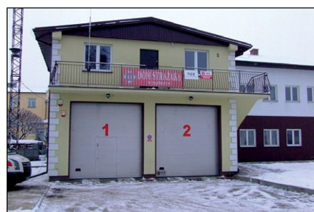
Wykonano kotłownię gazową w OSP Paprotnia
