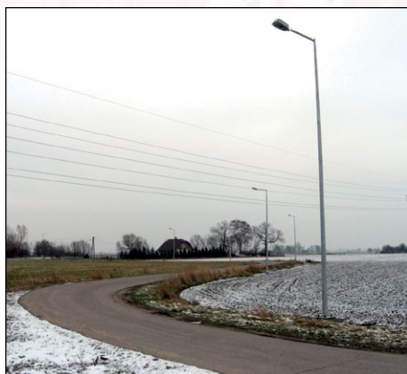
Skrzelew – oświetlenie drogi
