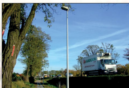
Oświetlenie chodnika ul. Sochaczewskiej
