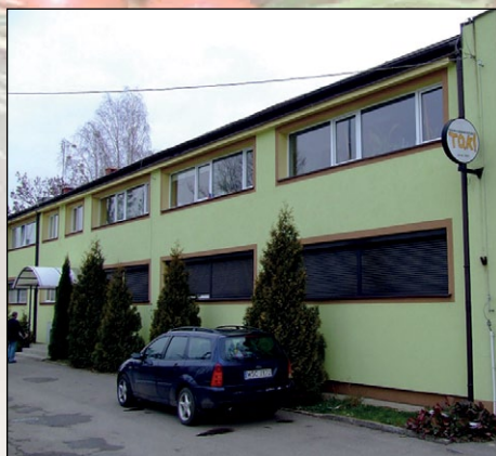
Teresiński Ośrodek Kultury – modernizacja instalacji elektrycznej i c.o.
