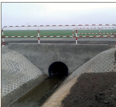
Zmodernizowano przepust pod drogą Hermanów – Kawęczyn
