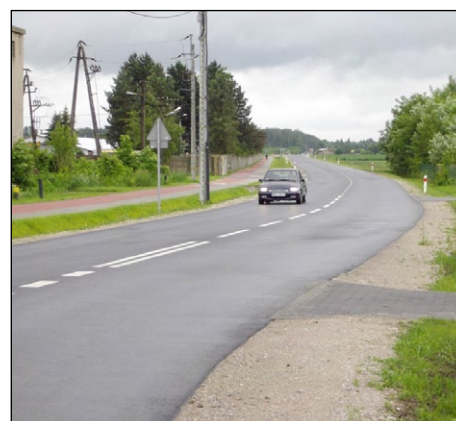
Zakończono I etap budowy „obwodnicy” Teresina
