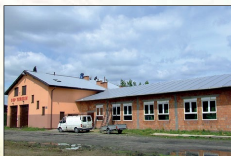
OSP Teresin – nowy dach, ogrodzenie i miejsca postojowe
