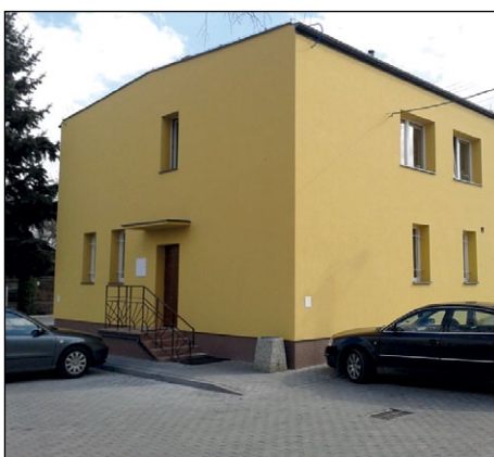
Termomodernizacja budynku Urzędu Gminy Teresin i podłączenie do sieci gazowej
