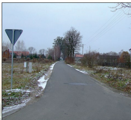
Zmodernizowana droga w Izbiskach
