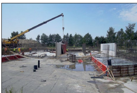
Budowa Oczyszczalni Ścieków w Granicach
