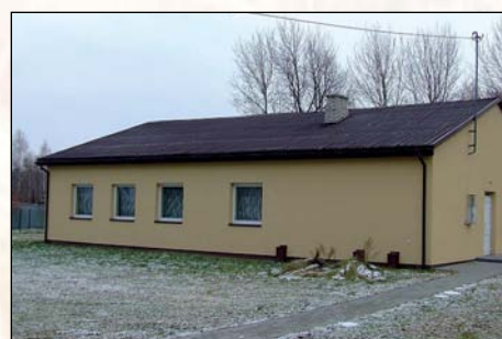
Świetlica wiejska w Masznie – docieplenie stropu i prace wewnętrzne
