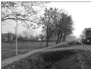
I etap oświetlenia chodnika wzdłuż ulicy Sochaczewskiej
