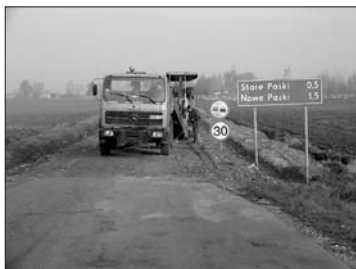
Modernizacja drogi do Nowych Pask
