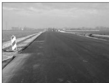
Budowa „obwodnicy” Teresina
