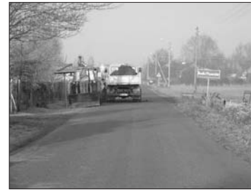
Budowa chodnika łączącego Dębówkę z Budkami Piaseckimi
