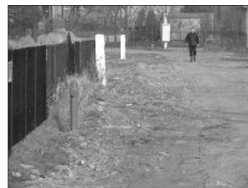
Wodociąg w Serokach-Parceli
