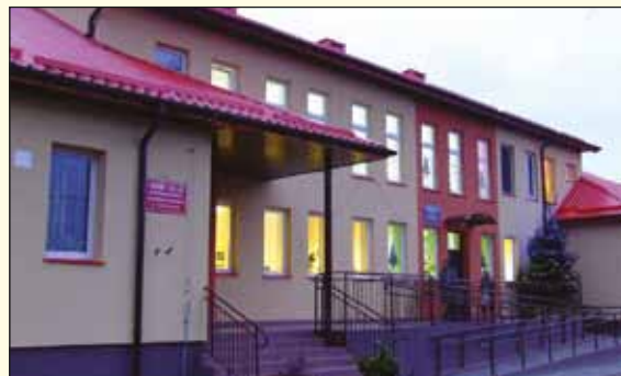
Budynek Gminnego Zakładu Gospodarki Komunalnej i Przedszkola w Teresinie
