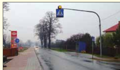
Sygnalizacja świetlna w Elżbietowie
