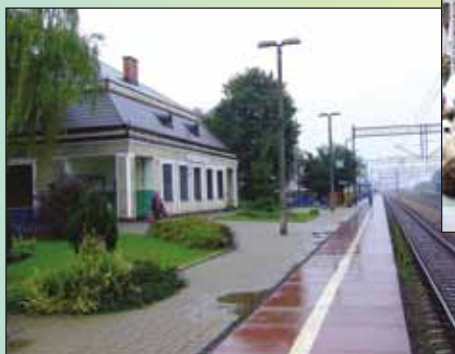
Na stacji PKP zainstalowano sieć monitoringu
