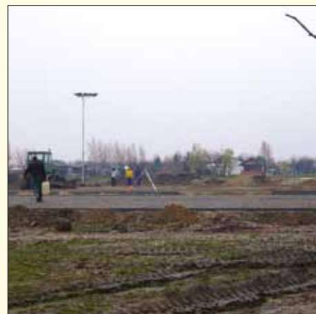
Budowa „Orlika” w Szymanowie
