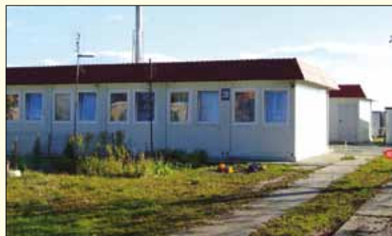
Kontenery socjalne w Szymanowie
