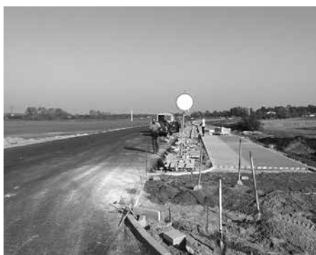
Na budowie ostatniego odcinka „obwodnicy”
