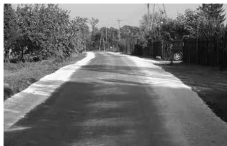
Droga w Serokach-Wsi (k. Stacji Uzdatniania Wody)
