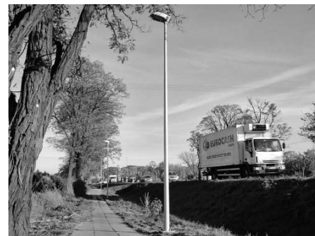
Kontynuacja budowy oświetlenia chodnika przy ul. Sochaczewskiej
