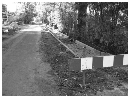
Kontynuacja budowy chodnika w Budkach Piaseckich
