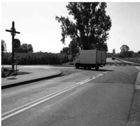
Przebudowane skrzyżowanie przed mostem w Szymanowie
