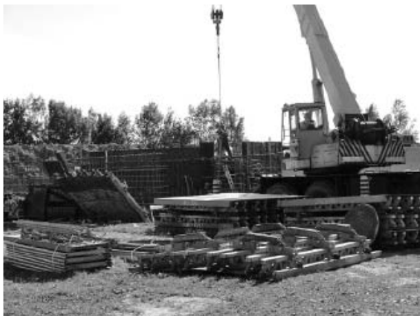
Rozbudowa Oczyszczalni Ścieków w Granicach
