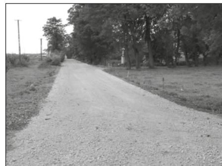
Droga w Topołowie
