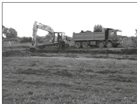
Budowa „Orlika” w Szymanowie
