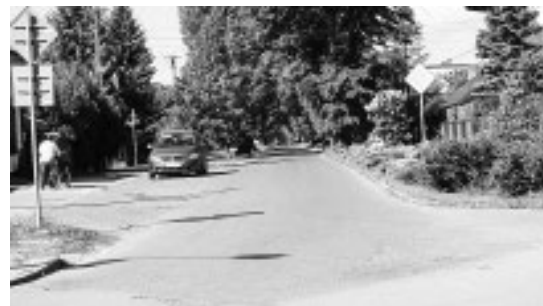
Ulica Lipowa przed generalnym remontem
