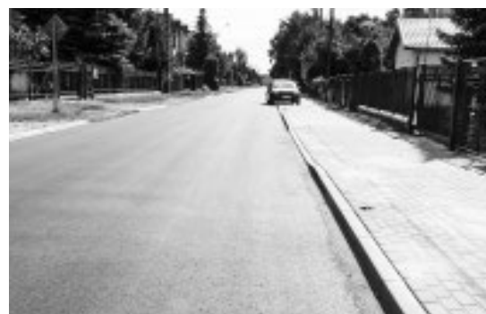
Zmodernizowana ul. Teresińska
