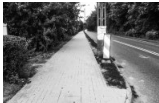
Przebudowany chodnik przy Al. XX-lecia
