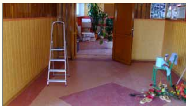
Prace remontowe w Gimnazjum w Teresinie
