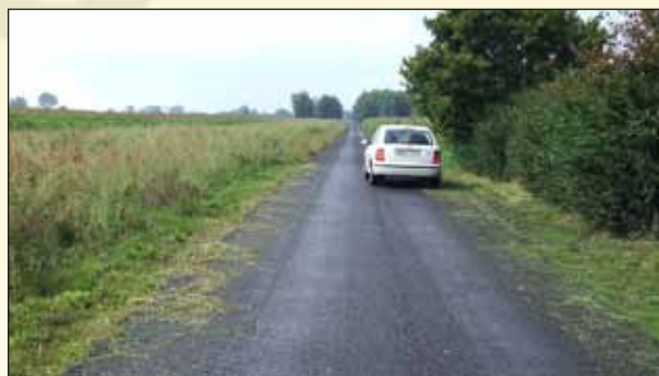
Droga Maurycew - Skrzelewo
