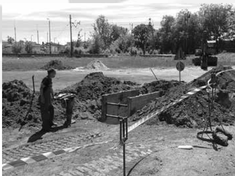
Prace przy budowie odwodnienia przy ul. o. M. Kolbego
