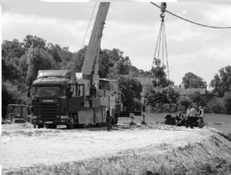
Początek prac mostowych na „obwodnicy” Teresina
