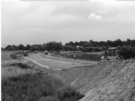
Na budowie II etapu „obwodnicy” Teresina
