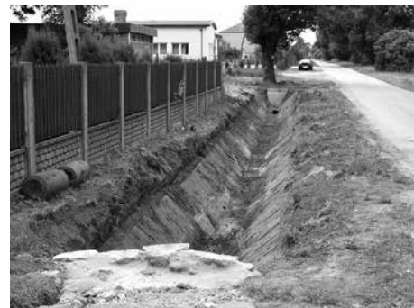
Odnowione rowy przydrożne w Skrzelewie
