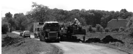
Trwają prace przy budowie ostatniego odcinka „obwodnicy”
