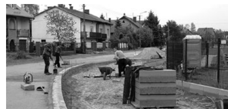
Budowa miejsc postojowych przy placu zabaw w Granicach
