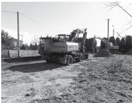
Budowa kanalizacji w Granicach
