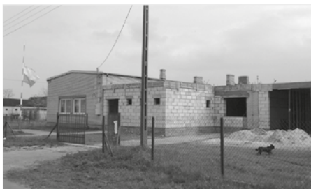
Rozbudowa strażnicy OSP w Skrzelewie
