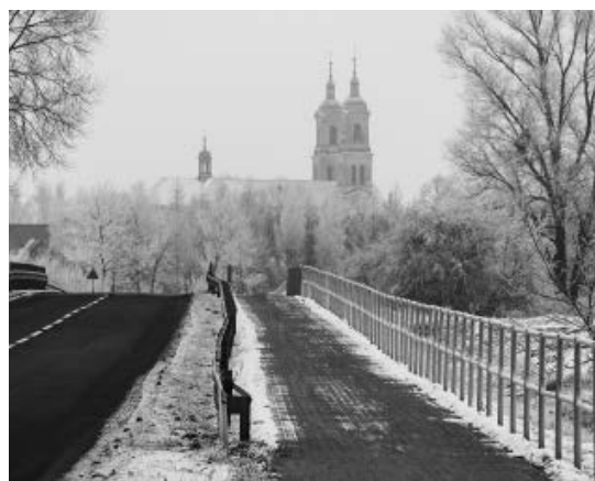
Kontynuacja oświetlenia ciągu pieszo-rowerowego
