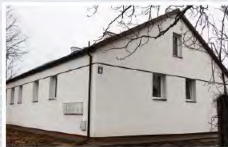
Seroki – wyremontowany dom komunalny
