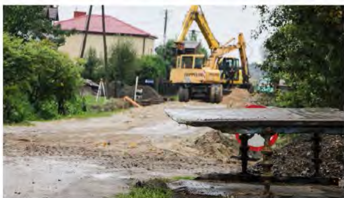
Teresin – kontynuacja kanalizacji (ul. Kasztanowa)
