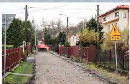
Teresin – modernizacja ul. Wąskiej
