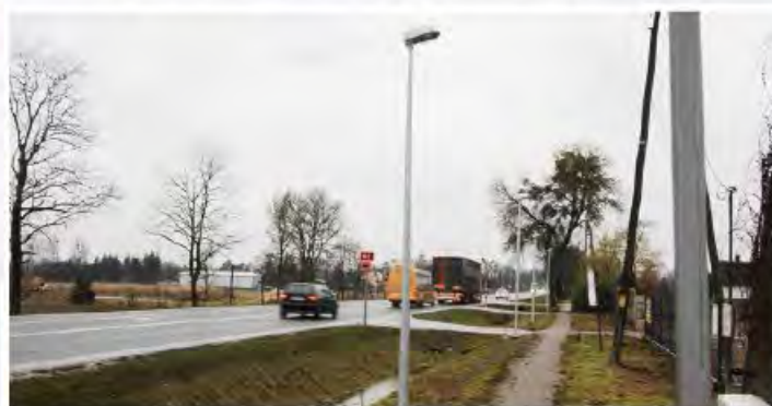
Paprotnia – kontynuacja oświetlenia chodnika przy ul. Sochaczewskiej
