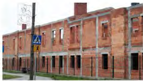
Teresin – budowa zaplecza sportowego GOSiR
