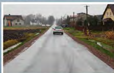
Maurycew – przebudowa drogi (I etap)
