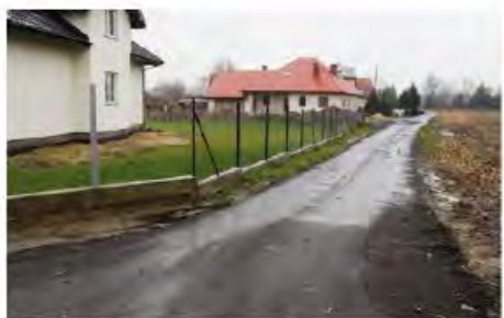
Granice – budowa kanalizacji
