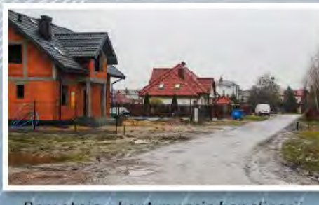
Paprotnia – kontynuacja kanalizacji sanitarnej (ul. Koralowa)
