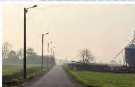
Pawłówek – oświetlenie drogi
