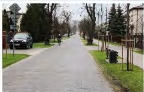
Teresin – przebudowa ul. Lipowej
