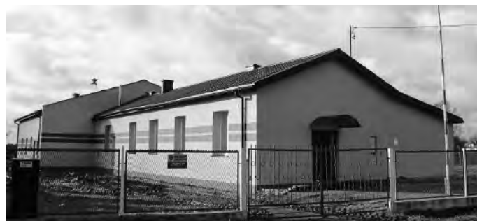
Budki Piaseckie – modernizacja strażnicy OSP
