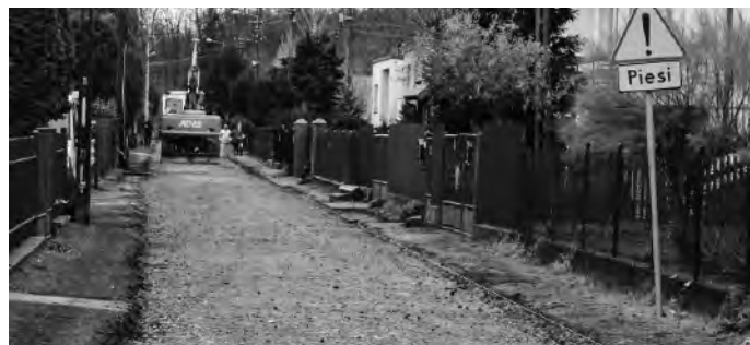
Teresin - przebudowa ul. Wąskiej
