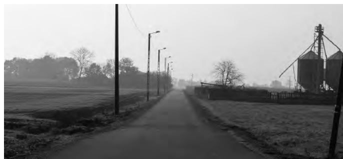
Pawłówek - oświetlenie drogi
