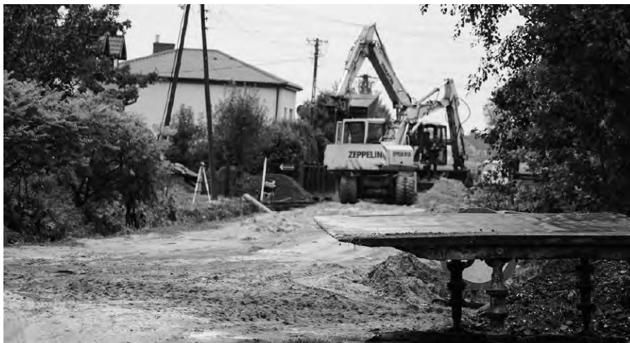
Rozbudowa sieci kanalizacyjnej w Teresinie
