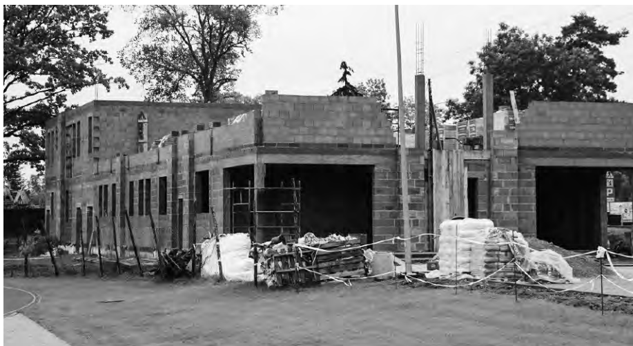
Budowa budynku zaplecza sportowego GOSiR
