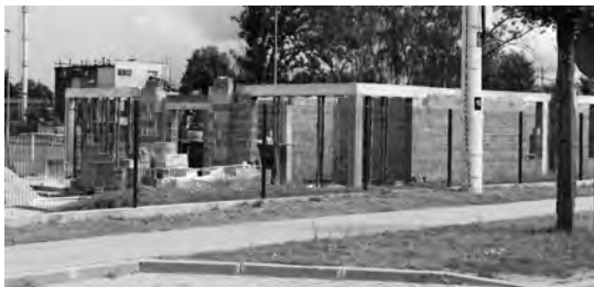
Budowa zaplecza sportowego GOSiR
