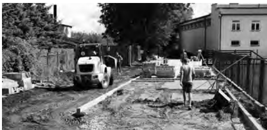
Budowa parkingu przy SP Paprotnia
