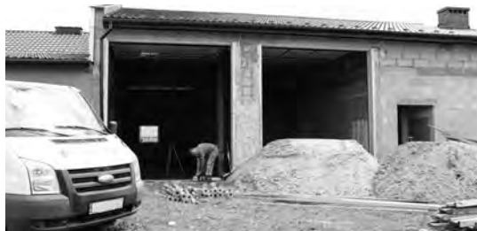
Prace przy strażnicy OSP Budki Piaseckie
