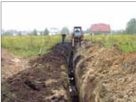
W trakcie budowy sieci wodociągowej
