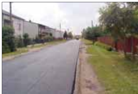
Budowa nakładki asfaltowej na ul. Spokojnej
