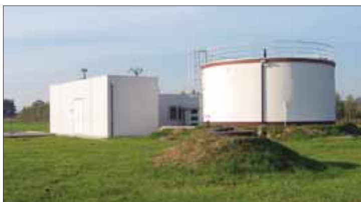
Stacja uzdatniania wody w Piasecznicy.
