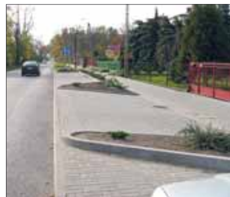
Chodnik i zatoki postojowe przy ul. Szymanowskiej
