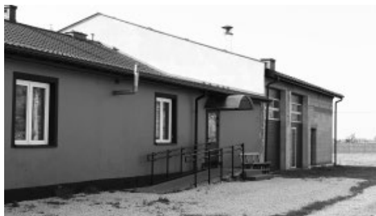
Budynek OSP Budki Piaseckie
