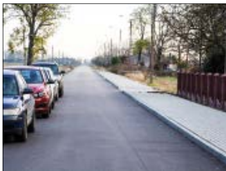
Pawłówek - zmodernizowana w kierunku Skrzewia
