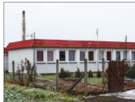
Szymanów - odnowiony budynek komunalny
