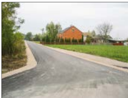
Stare Paski - droga po remoncie
