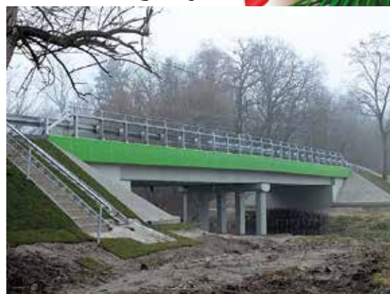
Zmodernizowany most w Pawłowicach
