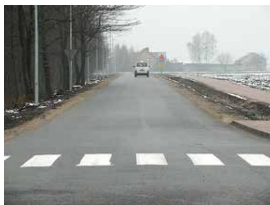
Łącznik obwodnicy z drogą do Szymanowa
