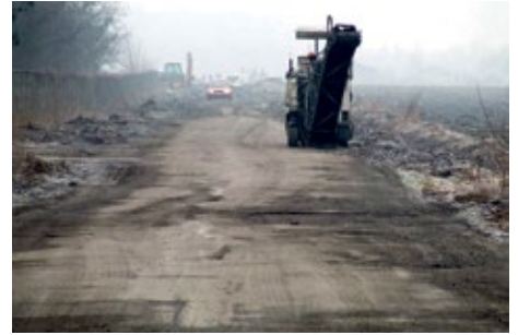
Na budowie I etapu
