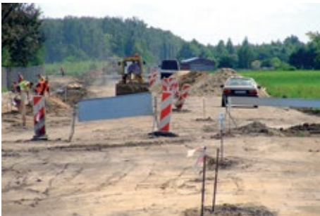
Na budowie I etapu
