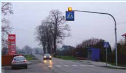
Sygnalizacja świetlna w Elżbietowie
