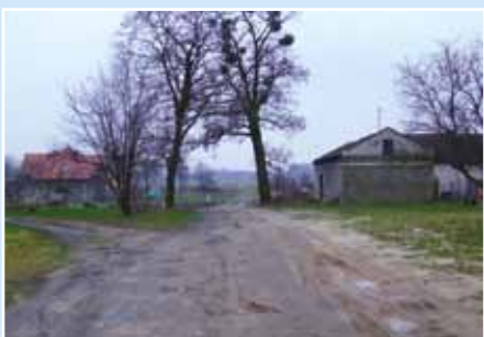
Wodociąg w Ludwikowie
