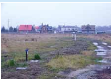
Wodociąg na ul. Spacerowej
