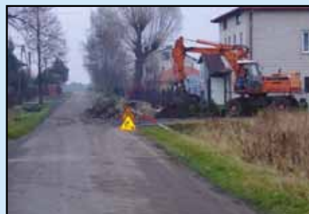
Połączenie studni na ul. Strażackiej do SUW Granice
