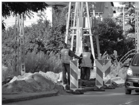
W ubiegłym roku położono nitkę gazociągu. Niebawem popłynie tędy gaz.
