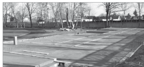
Fundamenty zaplecza sportowego
