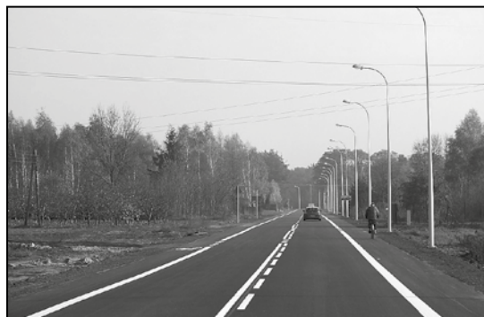
Przebudowana droga Kampinoska
