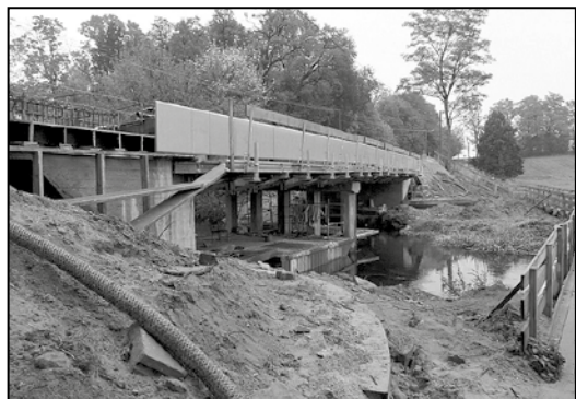
Przebudowa mostu w Pawłowicach
