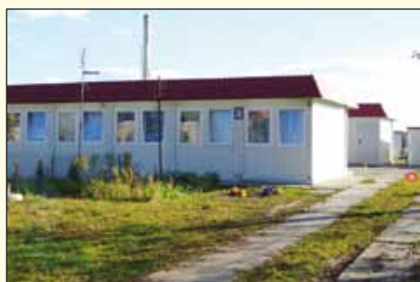
Przydomowa oczyszczalnia przy kontenerze socjalnym w Szymanowie
