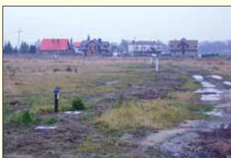
Wodociąg w Teresinie-Gaju
