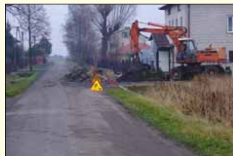
Połączenie studni na ul. Strażackiej do SUW Granice
