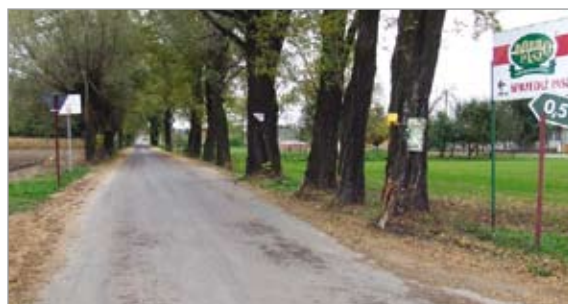
Nakładka asfaltowa w Izbiskach
