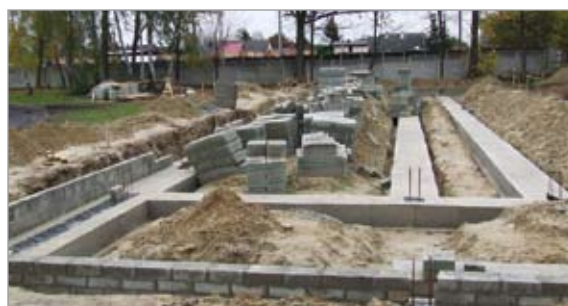
Fundamenty pod zaplecze sportowe w Teresinie
