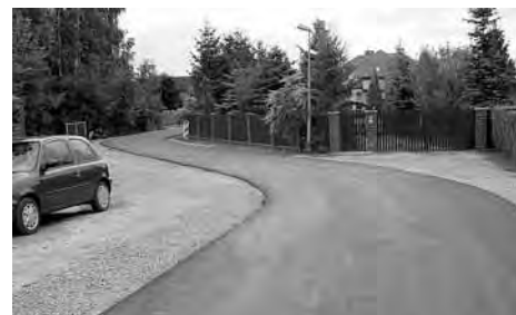
Nakładka asfaltowa na ul. Wesolej w Paprotni
