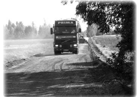
Modernizacja drogi Seroki — Gongolina
