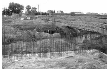
Budowa mostu w Mikołajewie
