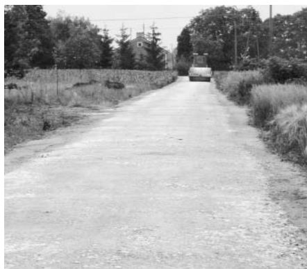
Utwardzona droga w Mikołajewie
