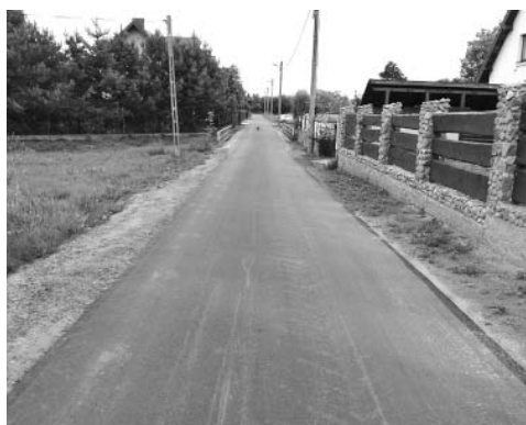
Asfalt pokrył ul. Klonową w Paprotni
