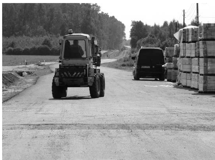
Budowa „obwodnicy” Teresina
