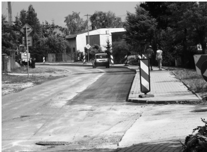
Budowa kanalizacji deszczowej w ulicy Kaskiej w Teresinie
