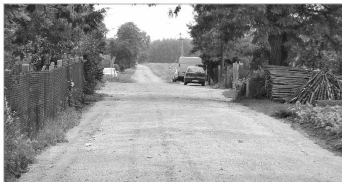
Utwardzona droga w Topolew
