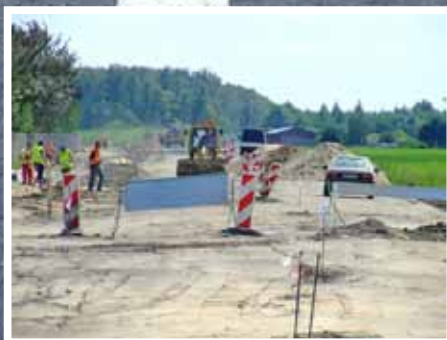
Rok 2011 trwa budowa przyszłej drogi
