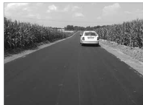
Droga asfaltowa w Pawłowicach - dokończenie
