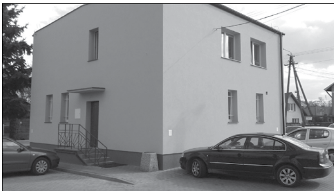
Wyremontowany budynek Urzędu Gminy Teresin (po byłej aptece)
