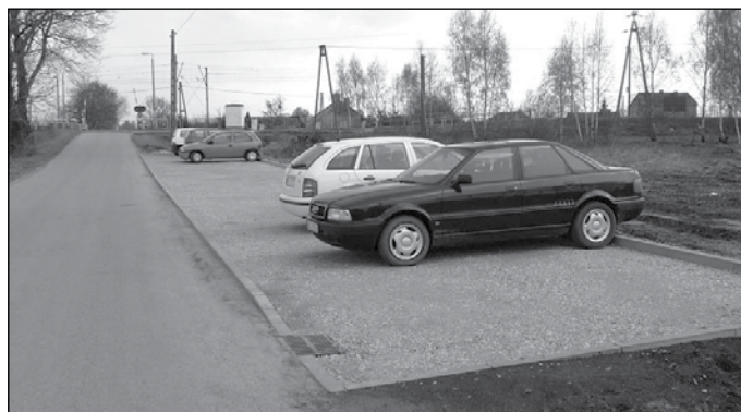
Utwardzone miejsca postojowe obok stacji PKP w Serokach
